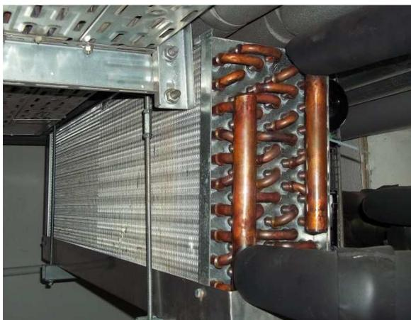
Bild 6: Wärmeübertrager zur Entfeuchtung Keller
