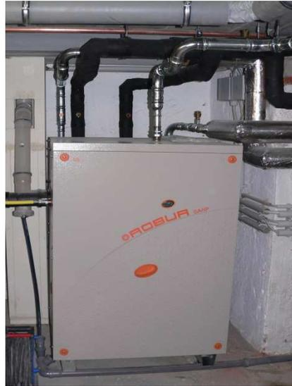
Bild 5: gasbetriebene Wärmepumpe
