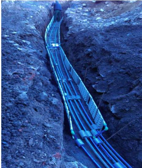
Bild 4: Graben mit Erdkollektoren vor dem Verfüllen
