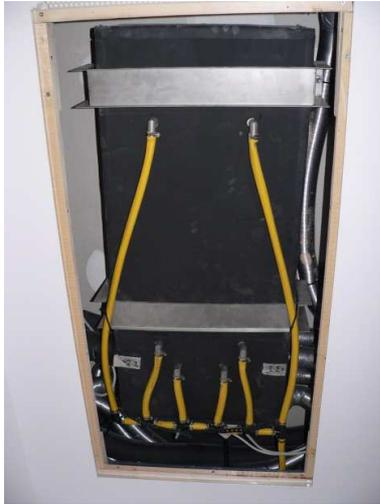
Bild 7: Lüftungsgerät mit WRG im Deckeneinbau (hier ohne Verkleidung)
