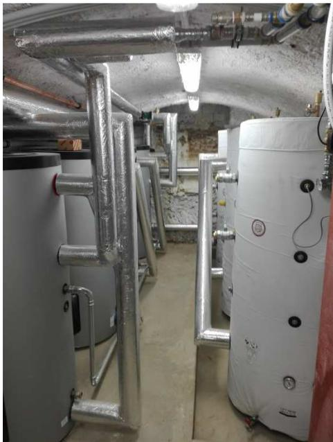
Bild 2: System Pufferspeicher
