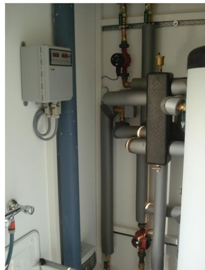
Heizungsinstallation mit Pufferspeicher für Brauchwasser, rechts im Bild (angeschnitten)
